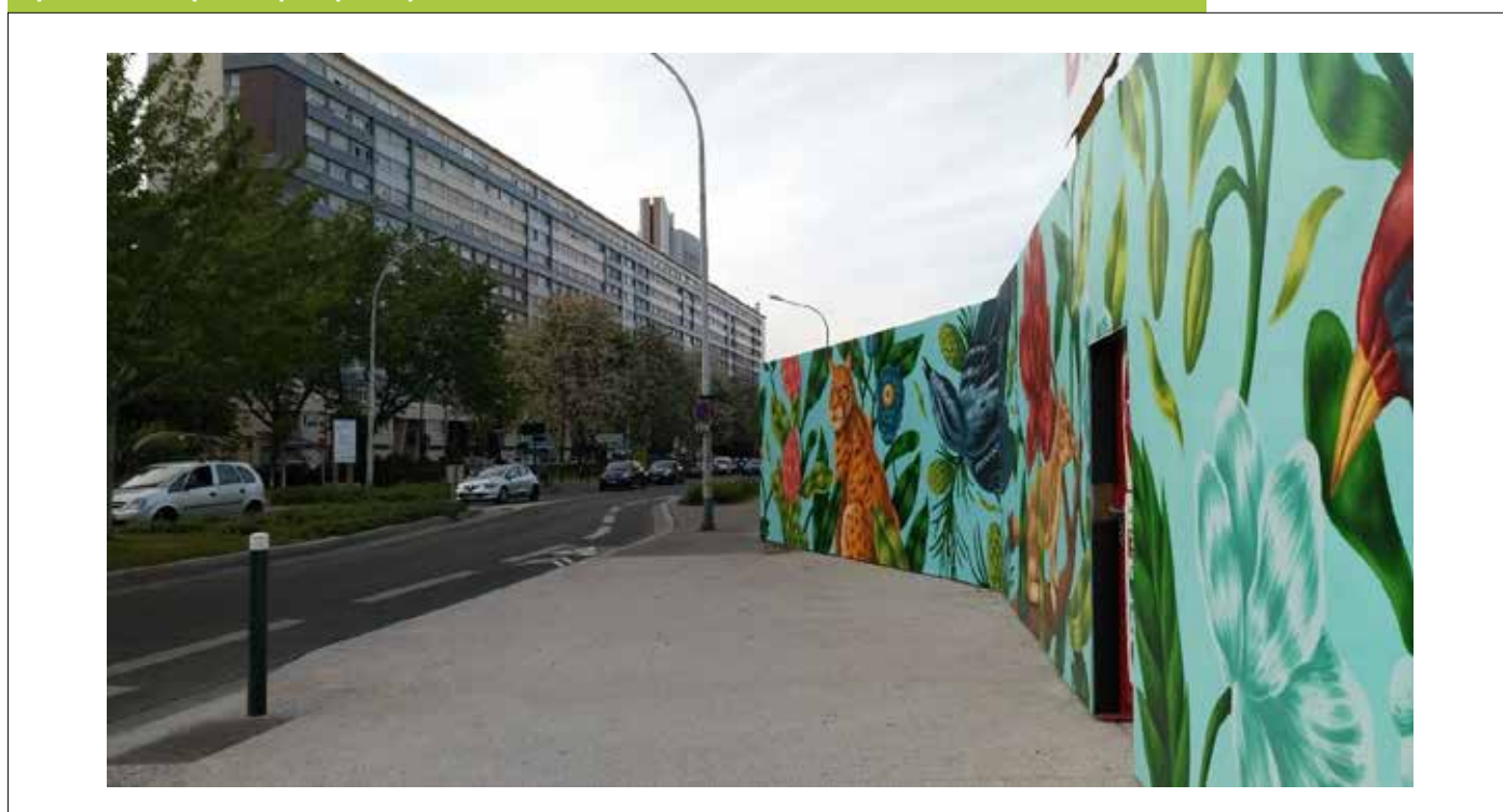
Figure 14 : Palissade de chantier, lors de la dernière tranche de construction du quartier République (2018)
